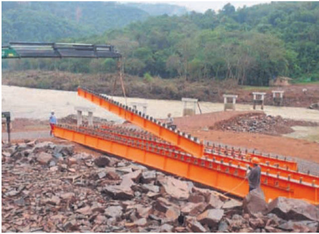
Pontes que será construída entre Cotiporã e Dois Lajeados.
